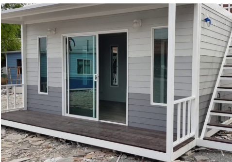
บ้านประกอบเสร็จ
